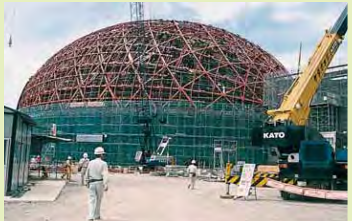
骨組みができ上がった恐竜ホール
