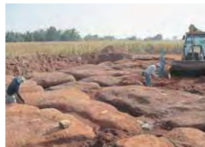
島のように見える現場
