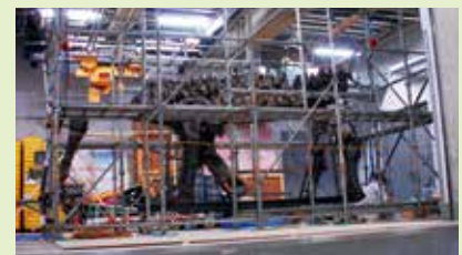
組み上げ途中
