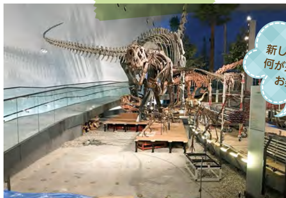
工事中の常設展示室（ティラノサウルス周囲の恐竜が取り払われている）
